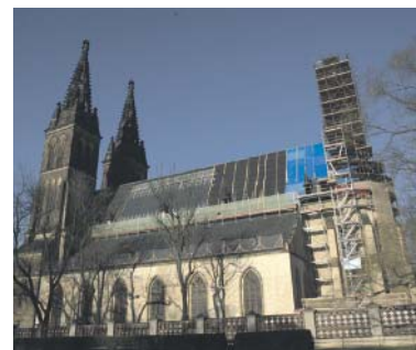
REKONSTRUKCE střechy již probíhá a potrvá ještě čtyři roky. Foto: VK
